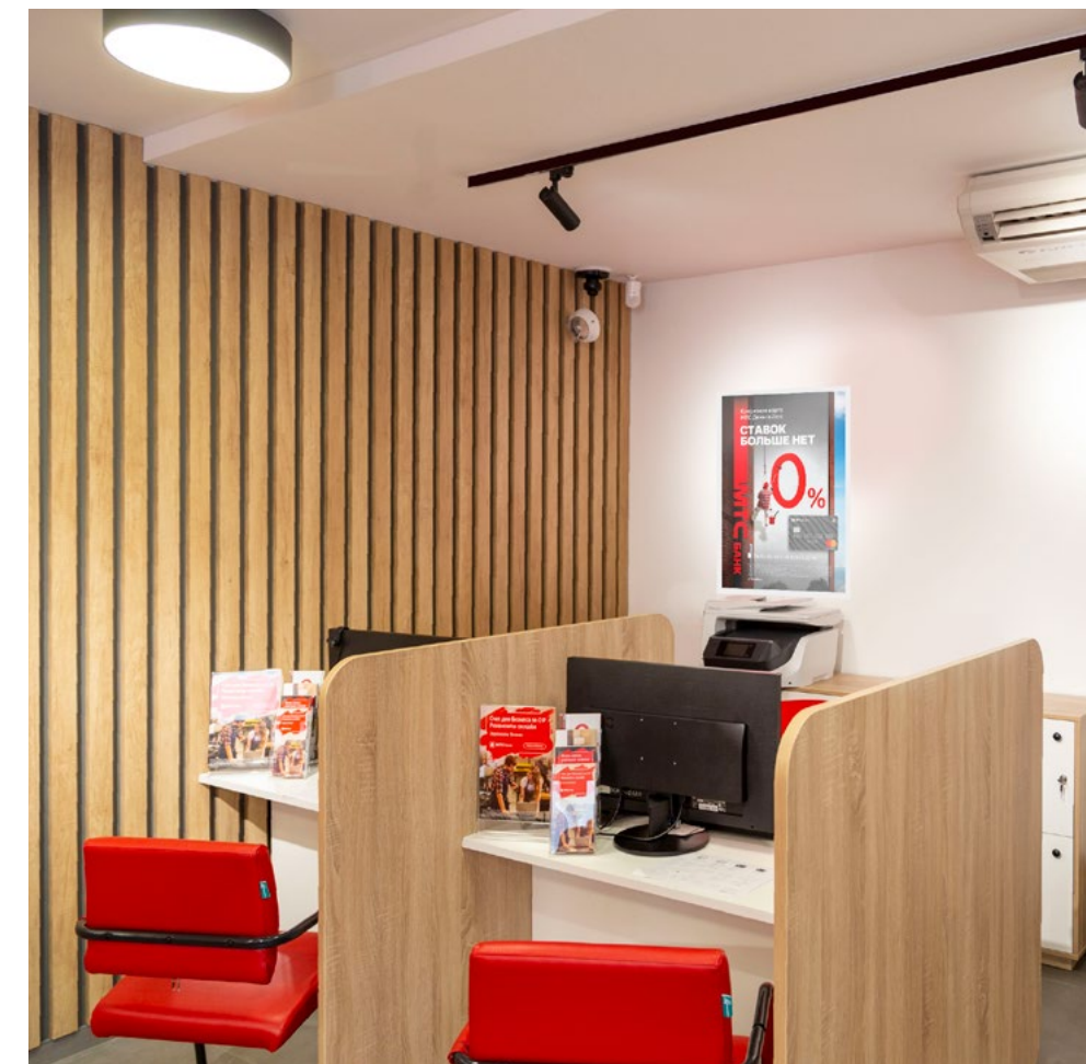
Отделка рейкой стены в операционном зале.
