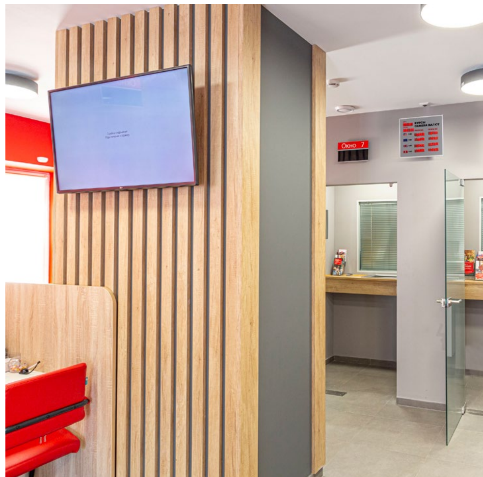
Колонна в операционном зале. Отделка рейкой с фронтальной и тыльной части.
